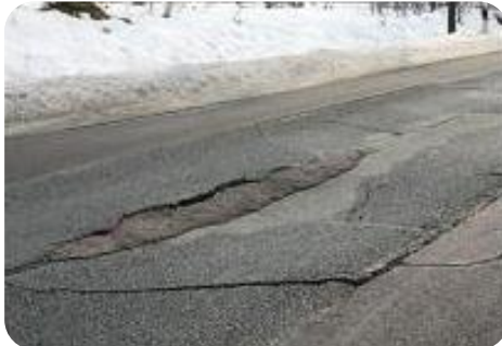
Sathi Kaplama-Asfalt Yol
