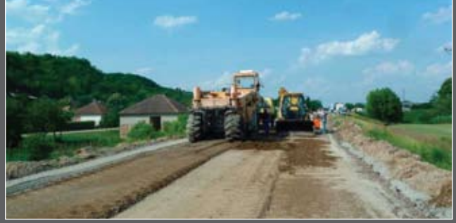
NovoCrete® - Çimento-toprak-eski asfalt tabakasının su eklenerek karıştırılması
