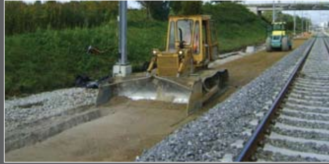
Yüzeyin düzeltilmesi
