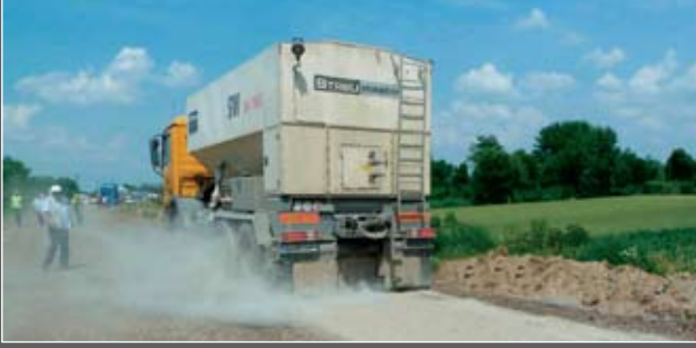
NovoCrete® - Çimento karışımının yayılması
