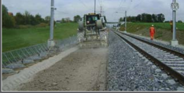
NovoCrete® - Çimento karışımının öğütülmesi
