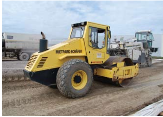
8 Yüzeyin düz silindir ile düzeltilmesi
