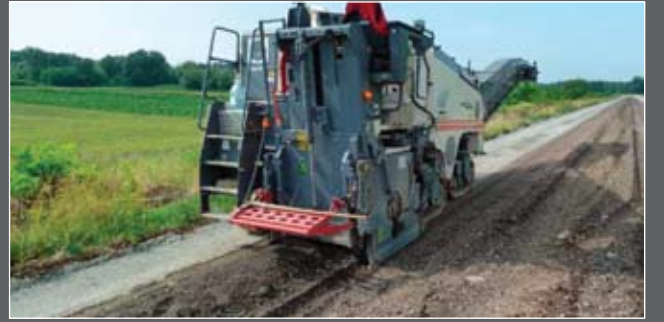
Eski asfalt tabakasının kırılması
