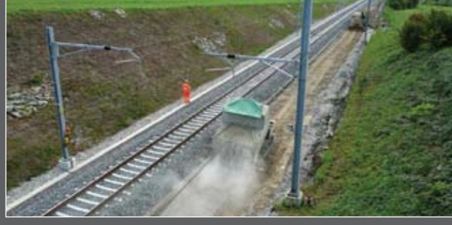
NovoCrete® - Çimento karışımının yayılması
