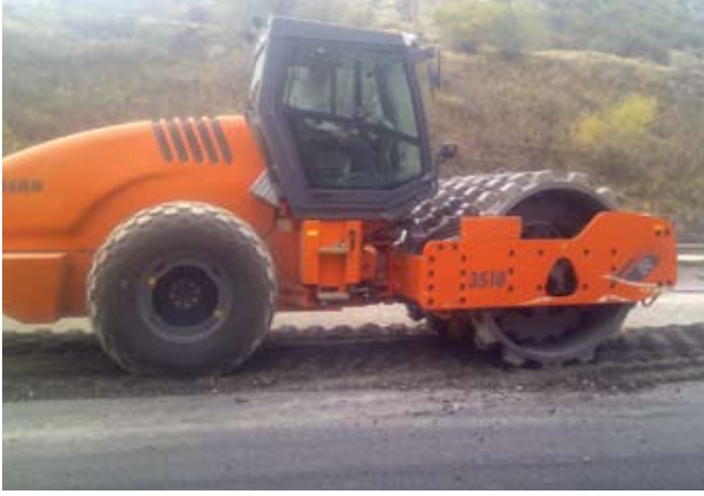
7 Yüzeyin vibrasyonlu silindir ile sıkıştırılması
