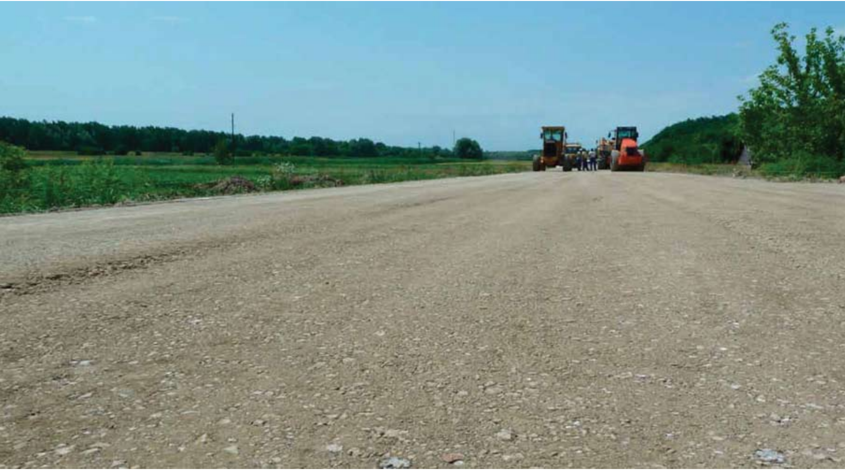
9 Sonuç: Zemin mekaniği bitmiş ve bitüm asfalt serilmeye hazır hale gelmiştir.
