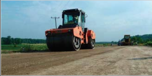
Çelik silindirle statik ve dinamik sıkıştırmanın yapılması
