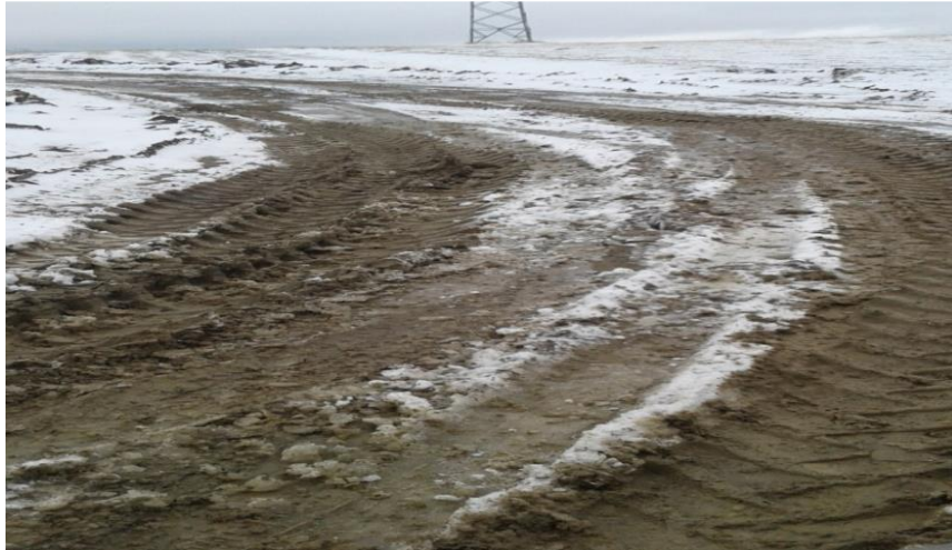
Figür-33 Uygulama Öncesi Km 275+100
