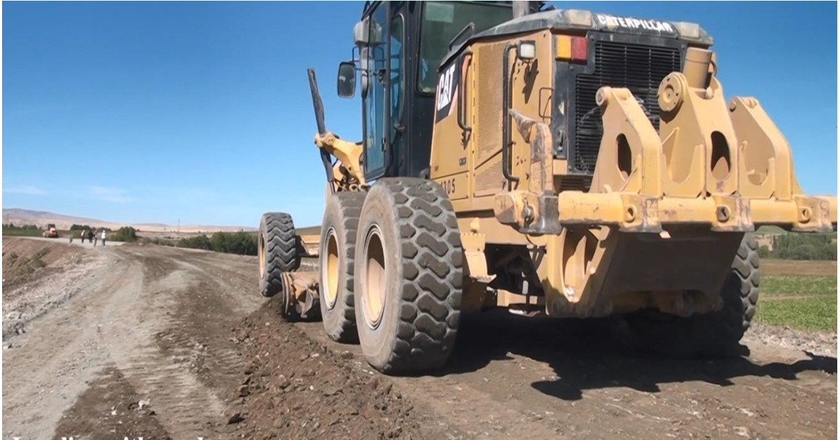
Figür- 16 Kot düzeltme işlemi
