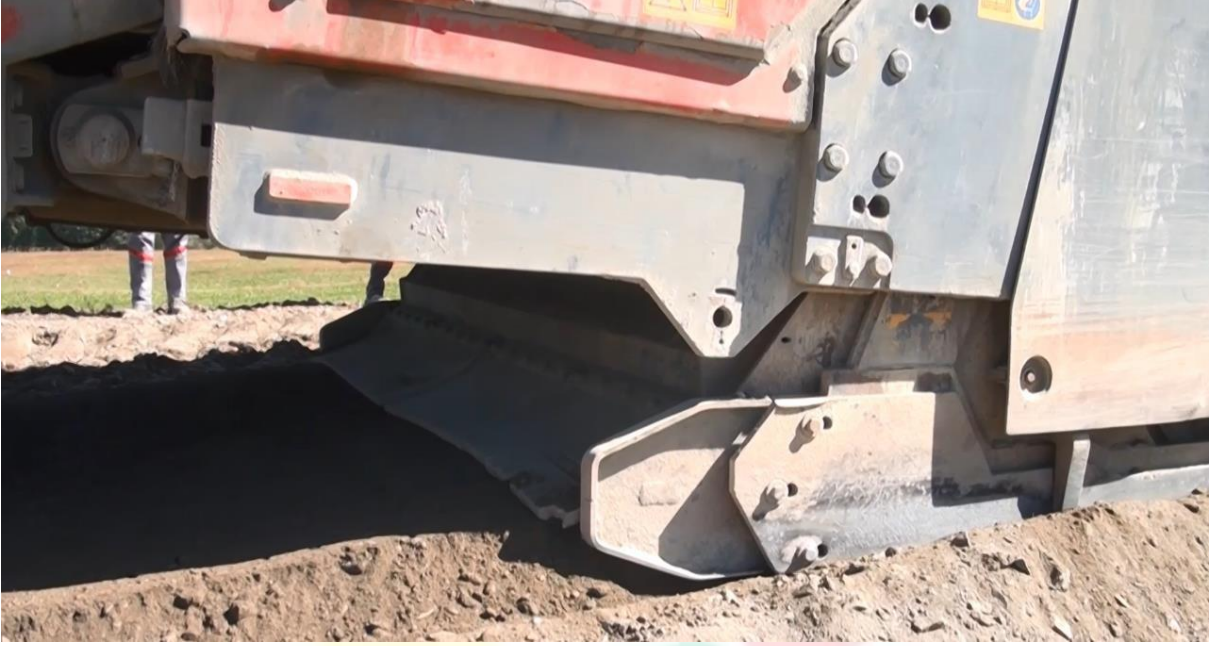
Figür-7 Birinci kademe frezeleme işlemi.
