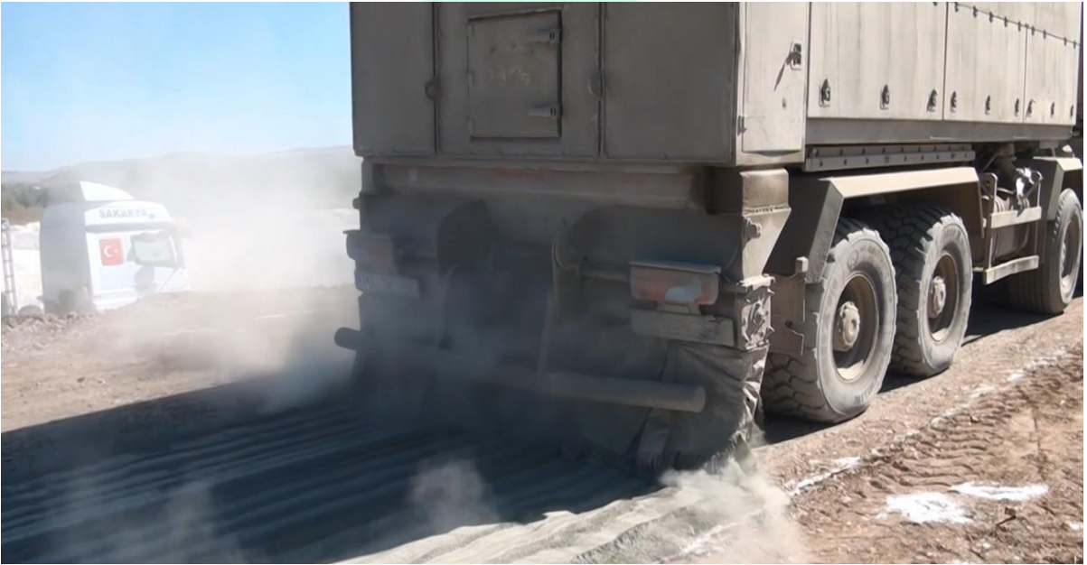
Figür-6 Dozajlı çimento serim işlemi.
