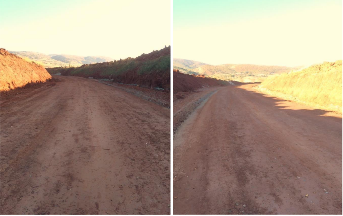
Figür-31,32 Km 241+500 NovoCrete® Uygulaması sonrası oluşan stabil taşıyıcı katman.
