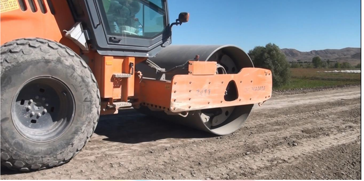
Figür-17 Düz silindir ile sıkıştırma işlemi.
