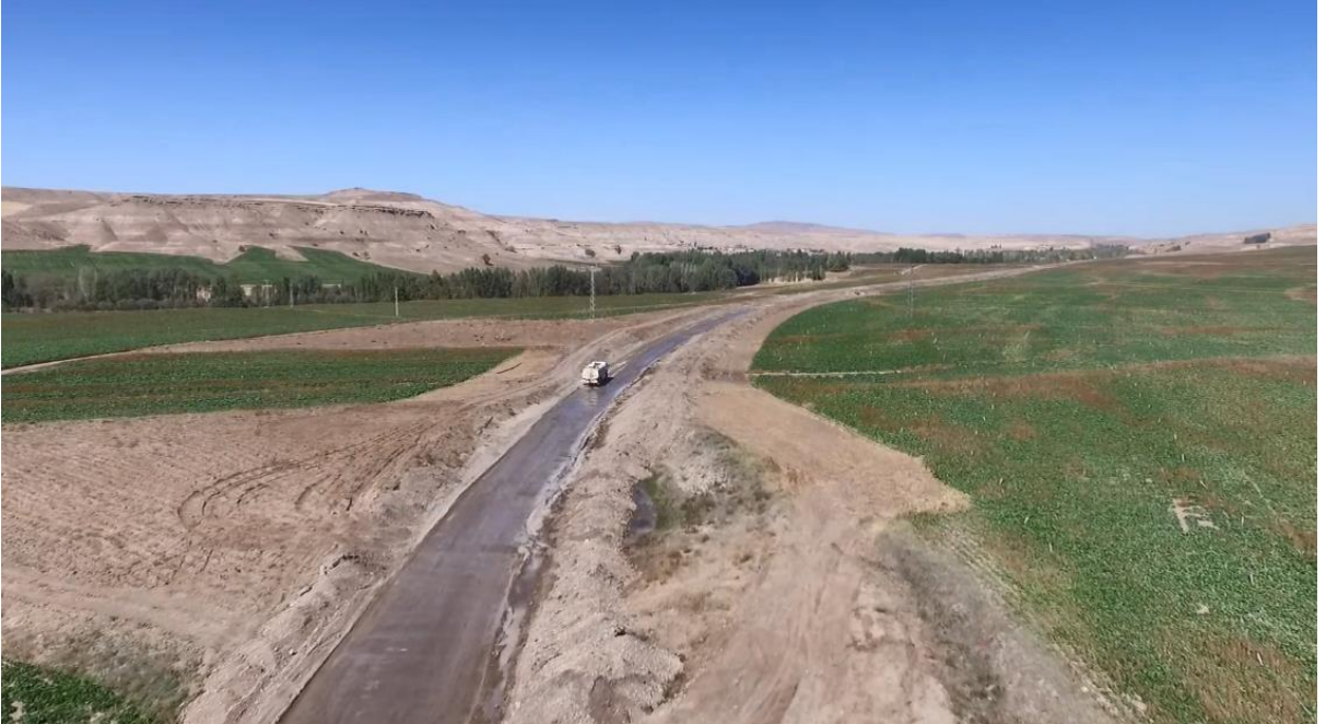
Figür-18 NovoCrete® katmanı sulama işlemi.
