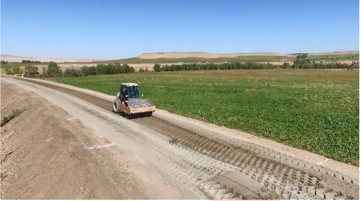
Figür-9 Keçi ayağı silindir ile ön sıkıştırma.
