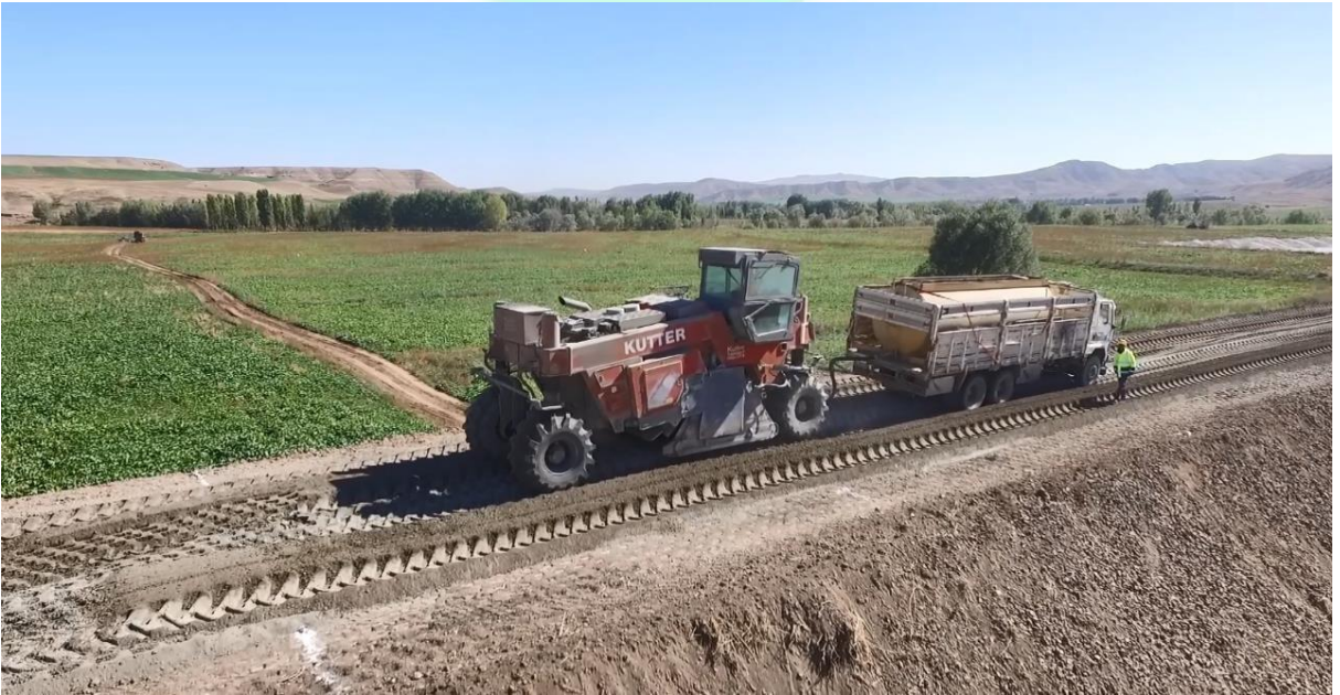
Figür-8 Frezeleme makinesi ve su tankeri bağlantısı.
