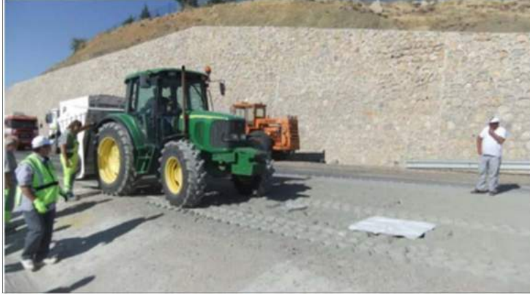
NovoCrete® serme işlemi ve serme kontrolü 02.09.2013
