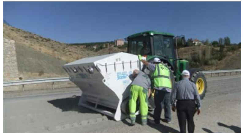
NovoCrete® serme ve serme kontrolü
