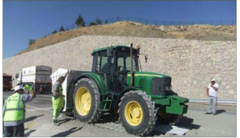
NovoCrete® serme işlemi ve serme kontrolü
