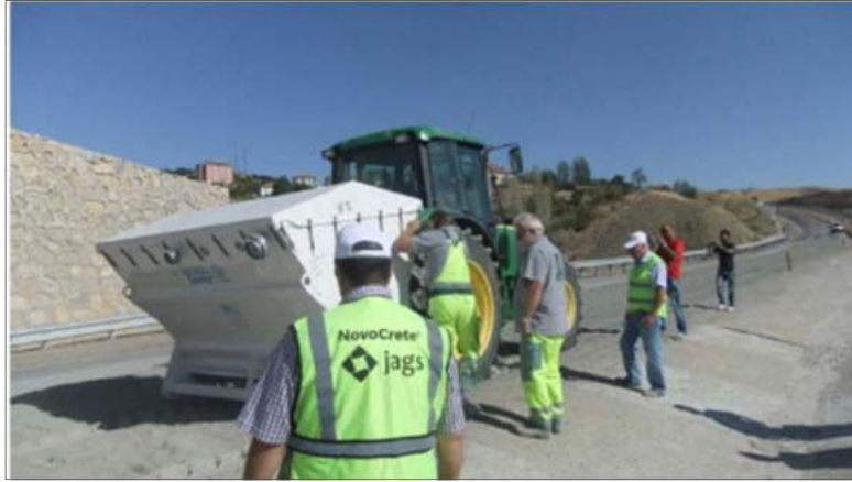
NovoCrete® serme ve serme kontrolü
