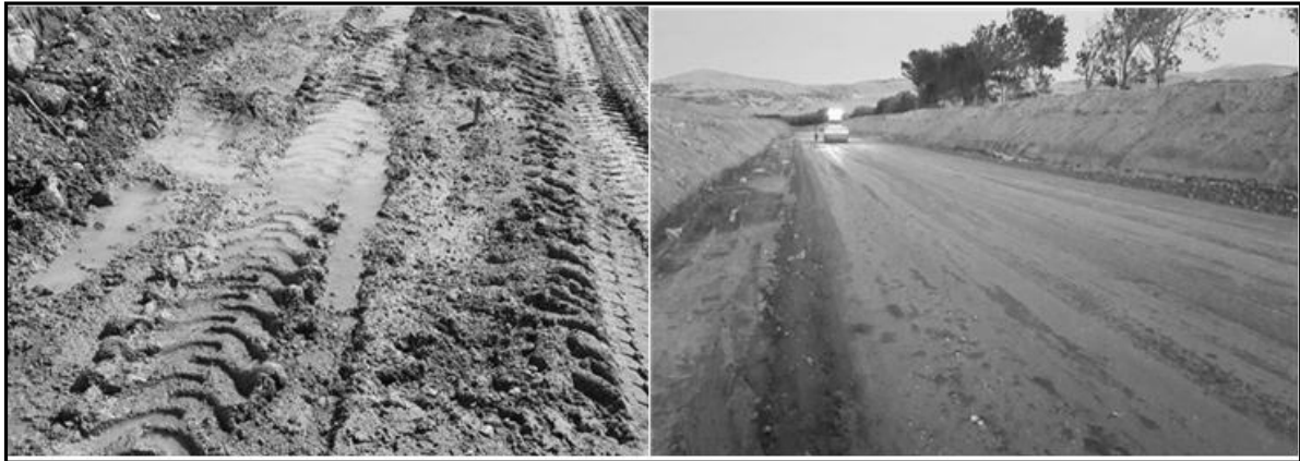
Şekil 6. NovoCrete® Teknolojisi ile iyileştirme öncesi ve sonrası zemin tabakasının ve yeraltısı seviyesinin görünümü.
