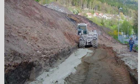
NovoCrete + çimento frezelenmesi
