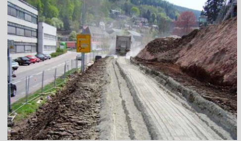
NovoCrete + çimento serilmesi
