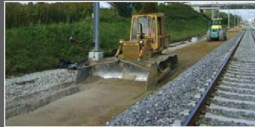
Yüzeyin düzeltilmesi
