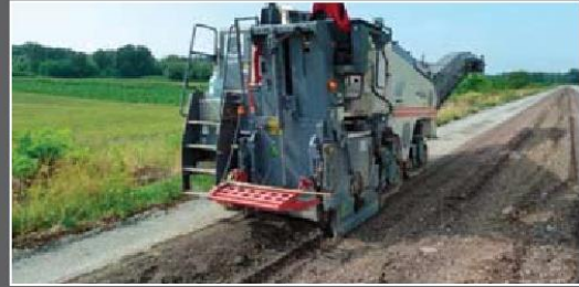
Eski asfalt tabakasının kırılması
