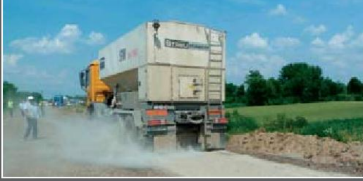
NovoCrete® - Çimento karışımın yayılması
