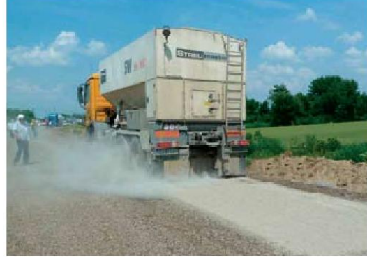
4 Yayma aracı ile toprak üstüne çimento ve NovoCrete® karışımının serilmesi
