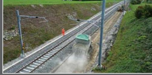
NovoCrete® - Çimento karışımının yayılması
