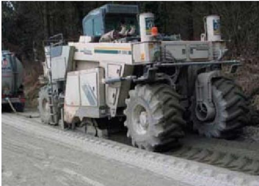
5 Toprak karıştırma aracı ile çimento ve NovoCrete® karışımının sulanarak karıştırılması
