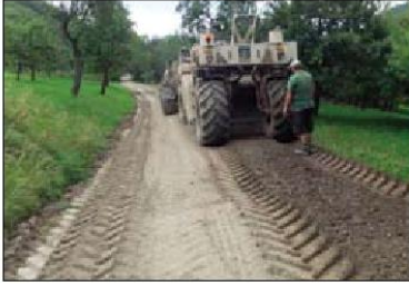
Pfullingen-Neu Buch, Almanya Uygulama Tarihi: Temmuz 2011 Gerekli Süre: 3 gün Katkı: 62 kg/m 2 (çimento %98 + NovoCrete % 2) Kazma derinliği: 30 cm
