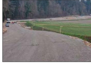
Bünzen, İsviçre Uygulama Tarihi: Şubat 2011 Gerekli Süre: 2 gün Katkı: 60 kg/m 2 (çimento %98 + NovoCrete % 2) Kazma derinliği: 25 cm
