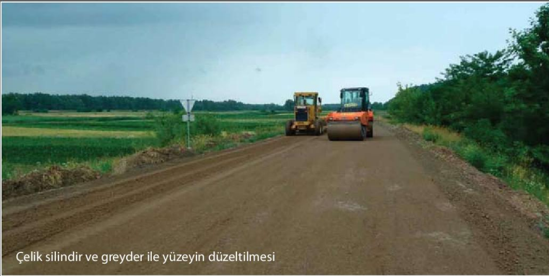
Çelik silindirle statik ve dinamik sıkıştırmanın yapılması
