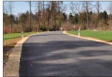
Witnau, İsviçre Uygulama Tarihi: Ekim 2010 Gerekli Süre: 4 gün Katkı: 62 kg/m 2 (çimento %98 + NovoCrete % 2) Kazma derinliği: 30 cm
