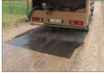
Hufingen-Behla, Almanya Uygulama Tarihi: Temmuz 2011 Gerekli Süre: 1 gün Katkı: 60 kg/m 2 (çimento %98 + NovoCrete % 2) Kazma derinliği: 30 cm
