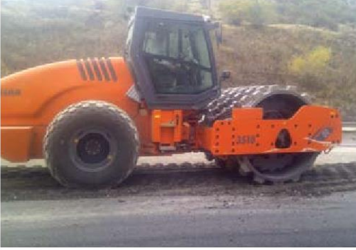
7 Yüzeyin vibrasyonlu silindir ile sıkıştırılması
