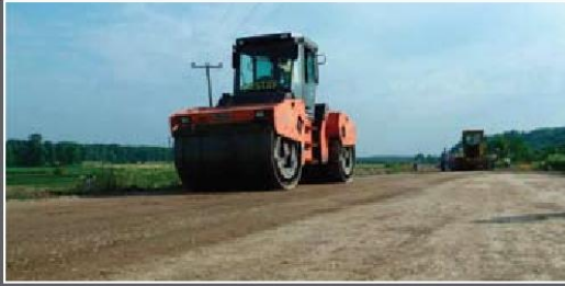
Çelik silindirle statik ve dinamik sıkıştırmanın yapılması
