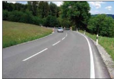
Gontenschwil, İsviçre Uygulama Tarihi: Ekim 2010 Gerekli Süre: 4 gün Katkı: 60 kg/m 2 (çimento %98 + NovoCrete % 2) Kazma derinliği: 30 cm
