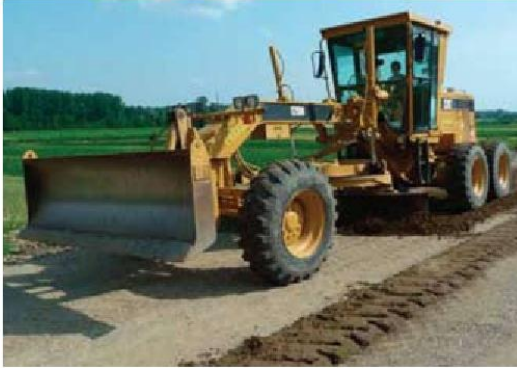
3 Greyder ile sahanın düzeltilmesi
