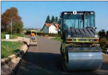
Rothenlachen, Almanya Uygulama Tarihi: Ekim 2010 Gerekli Süre: 5 gün Katkı: 60 kg/m 2 (çimento %98 + NovoCrete % 2) Kazma derinliği: 30 cm
