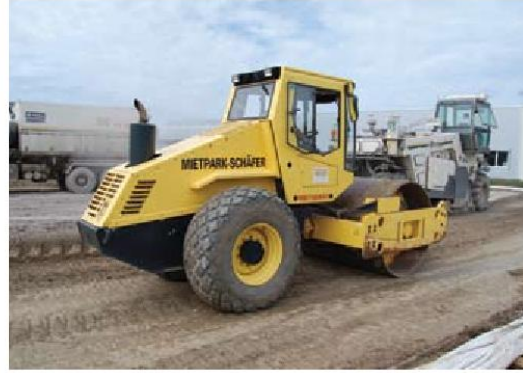
8 Yüzeyin düz silindir ile düzeltilmesi
