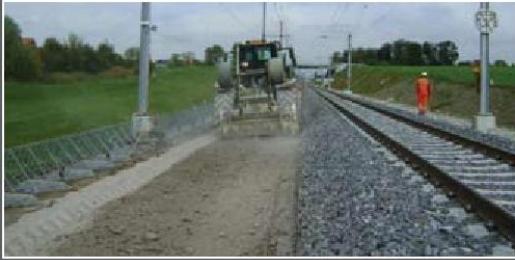
NovoCrete® - Çimento karışımının öğütülmesi
