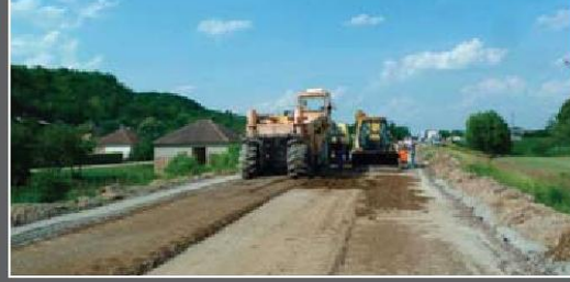
NovoCrete® - Çimento-toprak-eski asfalt tabakasının su eklenerek karıştırılması
