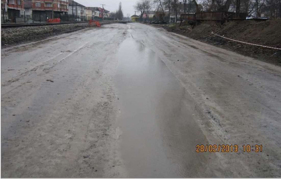
NovoCrete® imalat sonrası zeminin görünümü - 01.03.2013
