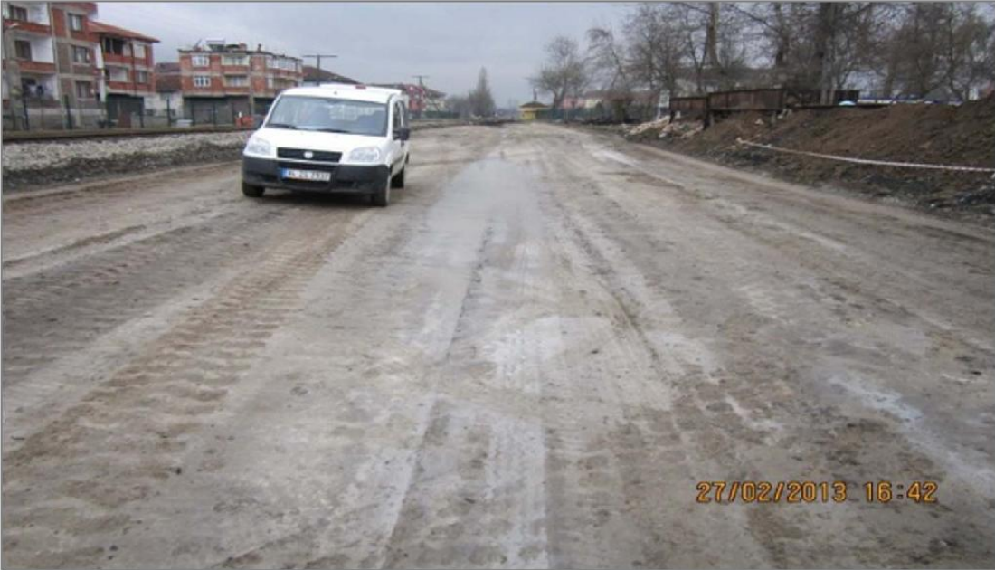
NovoCrete® imalatı sonrası zeminin görünümü - 27.02.2013
