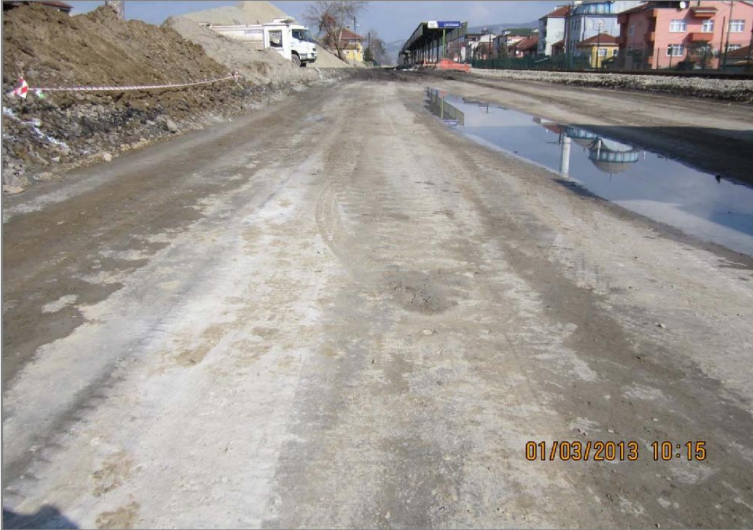
NovoCrete® imalat sonrası zeminin görünümü - 01.03.2013
